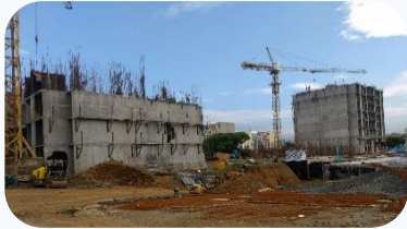
Construcción y Obras Civiles
